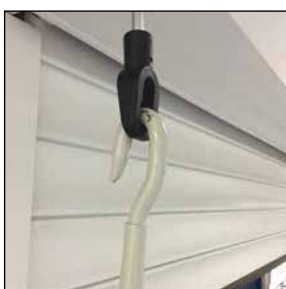
Handbetrieb zur Fehlerbeseitigung von innen standardmäßig (von außen als Option)
